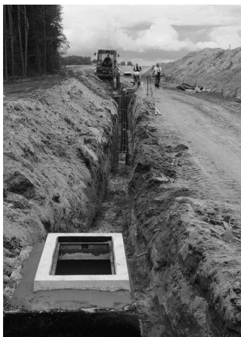
Rys. 34. Zamontowana studzienka kablowa
