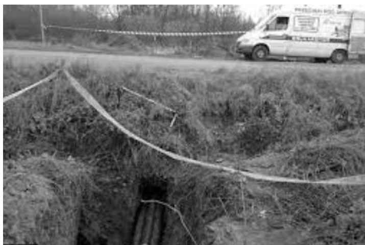
Rys. 31. Kanał kablowy umieszczony metodą przewiertu
