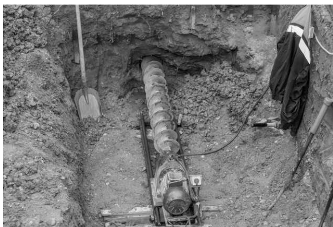
Rys. 30. Wykonywanie przewiertu
