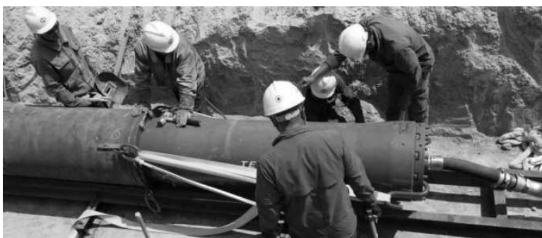
Rys. 28. Przecisk z ubijakiem umieszczonym za rurą stalową
